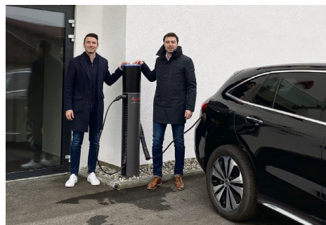
Erwin Thomas Schiegl & Stefan Schiegl an der Ladesäule Twin.
